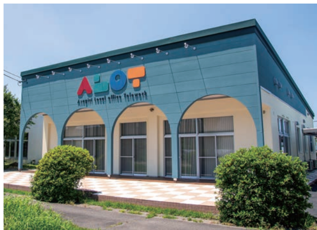
▲テレワーク施設ALOT（アロット）外観
