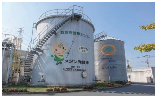
▲バイオマスセンターのメタン発酵槽
