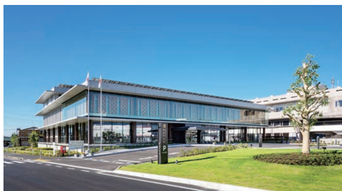
▲開成町役場(日本初のZEB庁舎)
