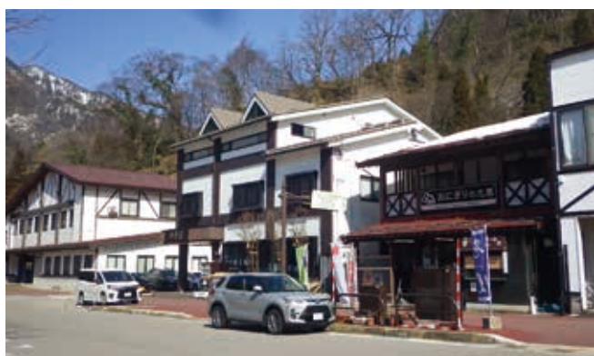
▲無電柱化工事後
