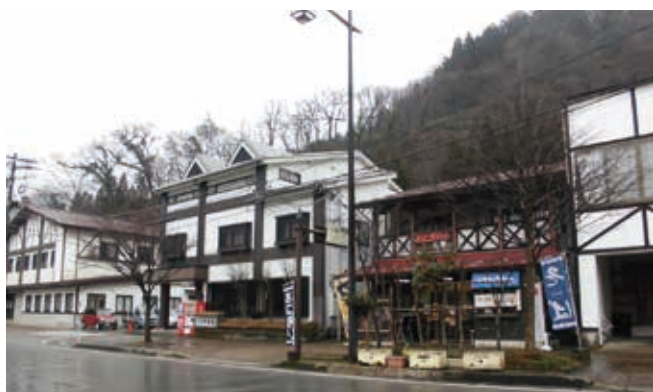
▲無電柱化工事前
