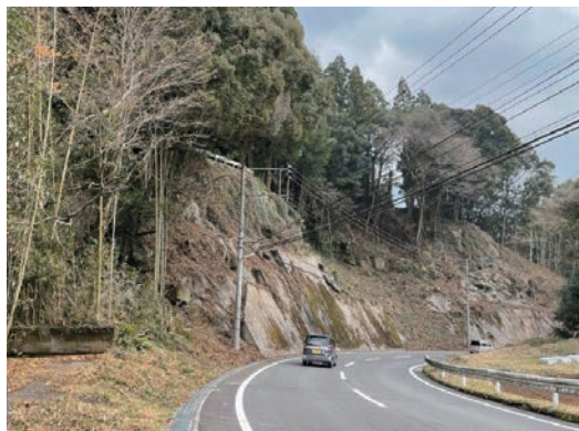
▲林道法面樹木等の伐採
