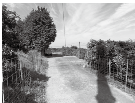
△ワイヤーメッシュの設置状況(早垣地区)
