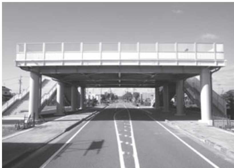
△道路上に建設した津波避難タワー
