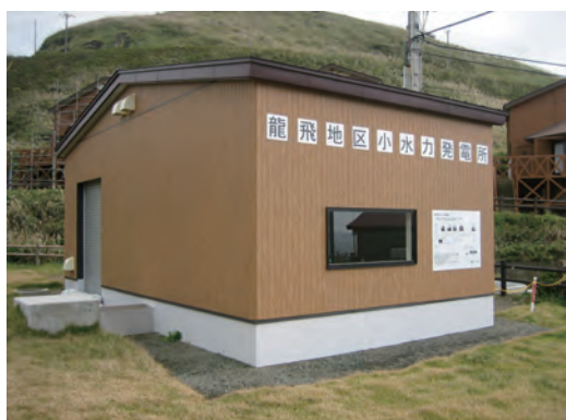
▲龍飛地区小水力発電所
