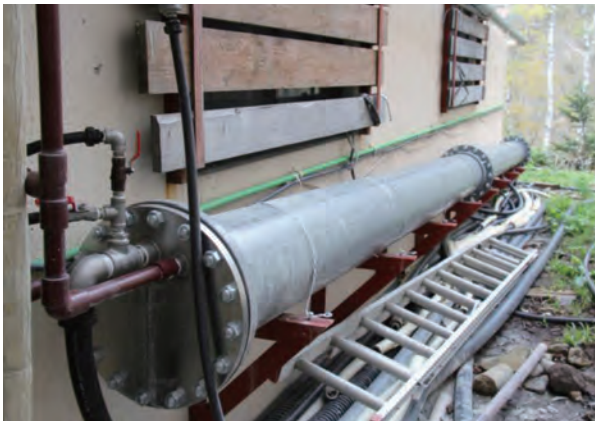
▶補助金で温泉熱利用設備（チューブ式熱交換器）を整備
