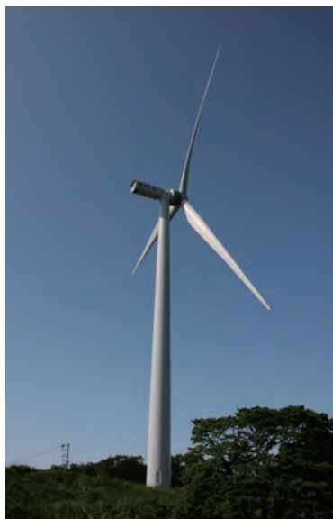
▶(株)津軽半島エコエネの風力発電機
