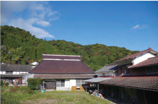
▶田舎暮らし研究サロン「改修中の古民家」
