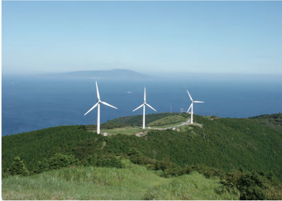
▶町営風車全景
