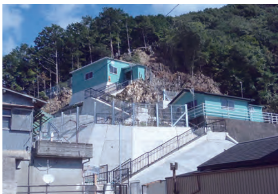
◀釜土避難所と第2釜土避難所
