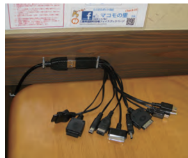
▲道の駅菰野ふるさと館に併設されているお食事処「マコモの里」に設置した充電スポット
